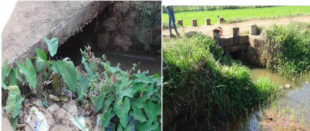
PHOTO 2. BUSES EN BETON ET OUVRAGE D'EQUILIBRE A DEMOLIR ET A REMPLACER
