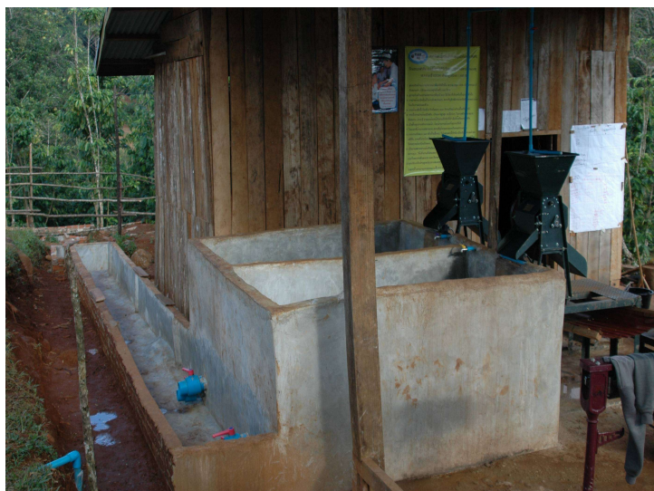
Photo 2 : Petite station de lavage avec canal de lavage
