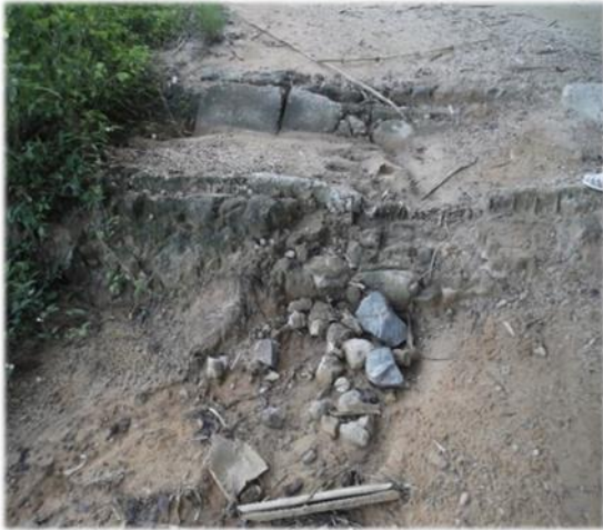
PHOTO 10. OUVRAGE DE DÉCHARGE ENDOMMAGÉ
