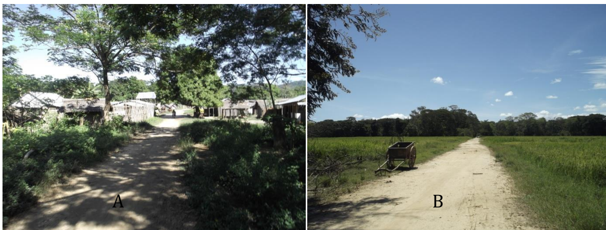
Photo 5. (A) Déplacement de l'axe vers la droite à Ambolodimaka ; (B) Maintien de la largeur avec rehaussement en profil en remblai de la piste avec des rizières à Ambodifinesy.
